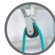
Sistema de polea y cuerda para operar la sección móvil de la escalera.
